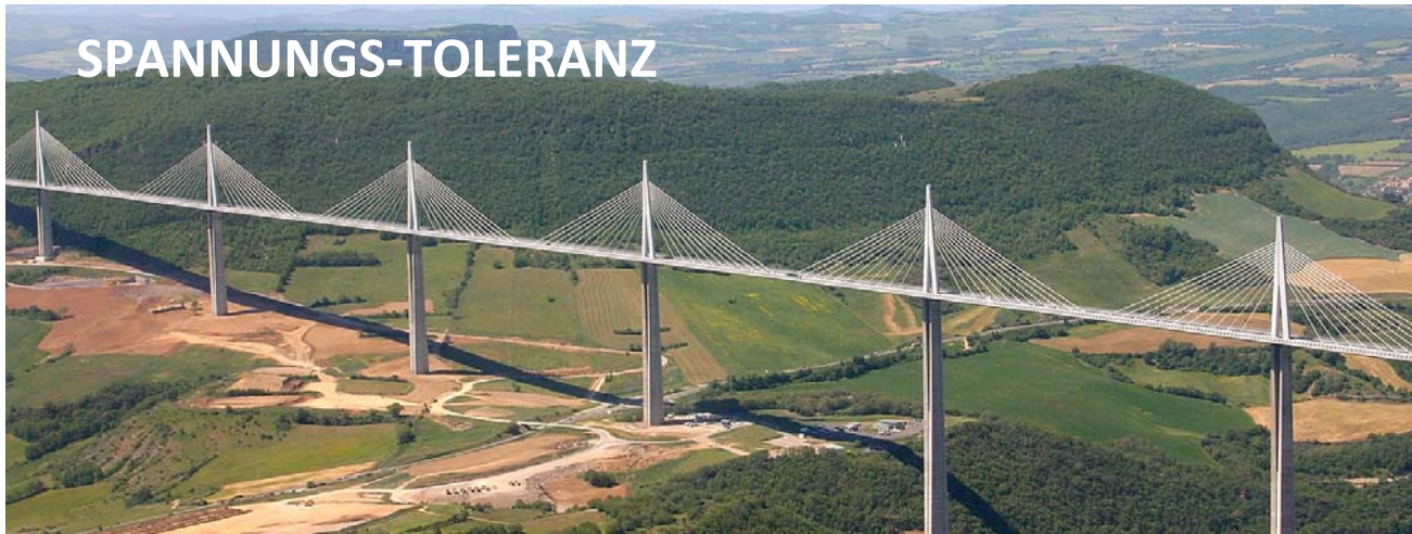
Viaduc de Millau, Foto © Mike Lehmann, 2005
